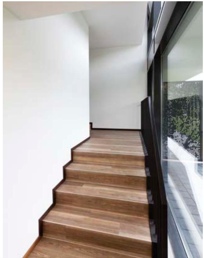
Verlegung Boden nur auf der Oberseite mit Treppen-Abschlussprofil
